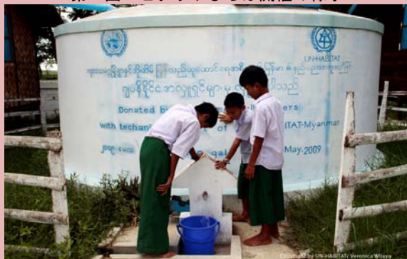
ミャンマー事業で整備された雨水集水タンク
